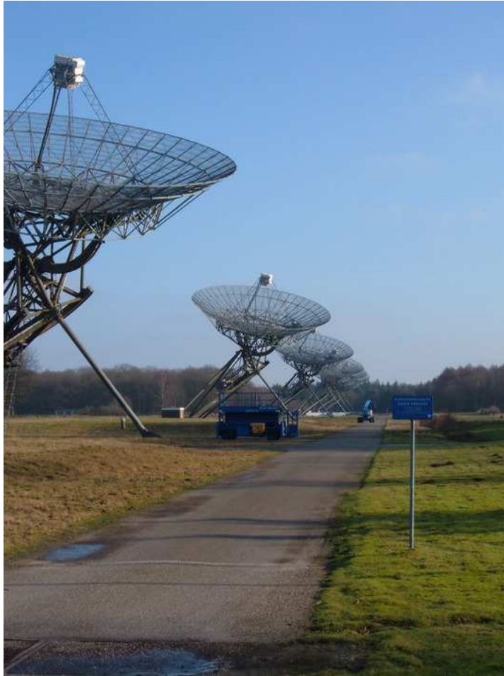
Figuur 1: Enkele schotelantennes van de Westerbork Synthese Radio Telescoop. De diameter van een schotel is 25 m.
