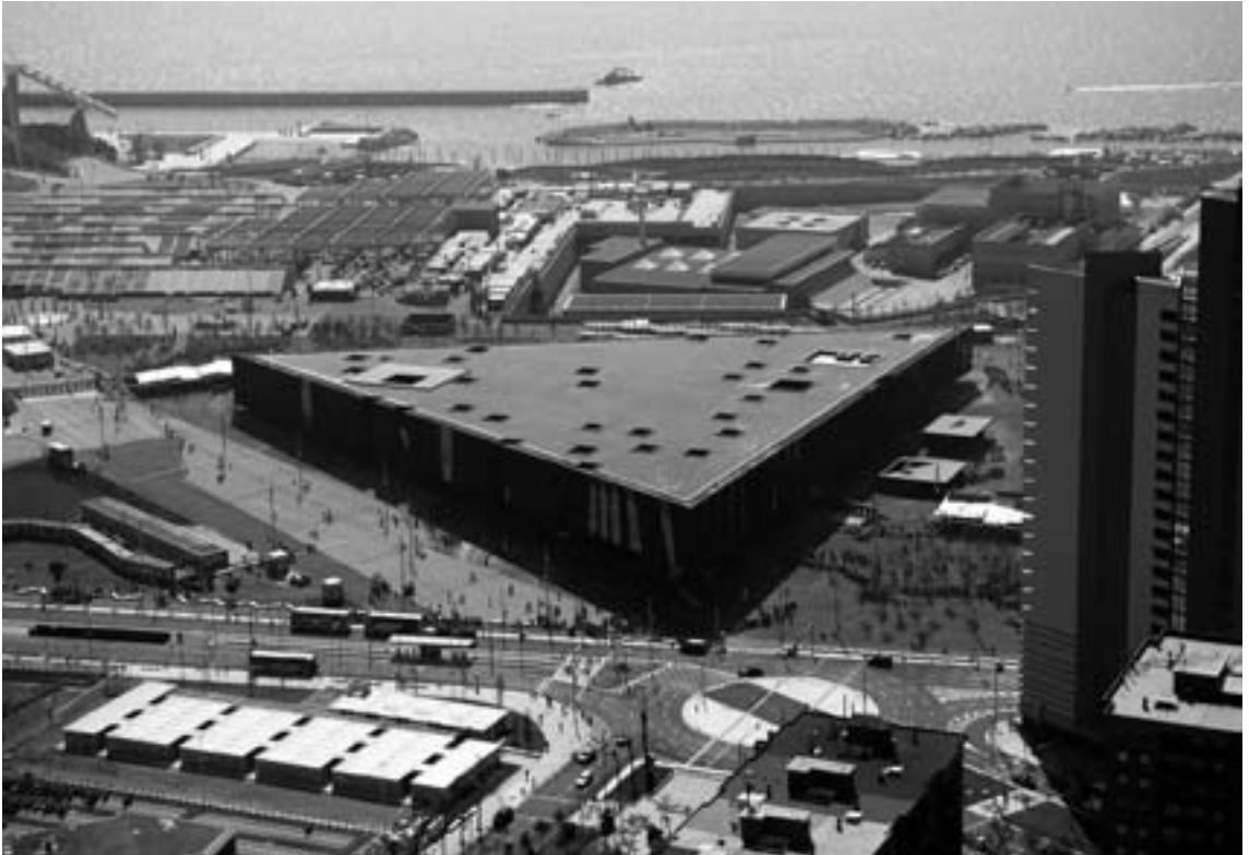
Forumgebouw (bron: Forum Barcelona)
