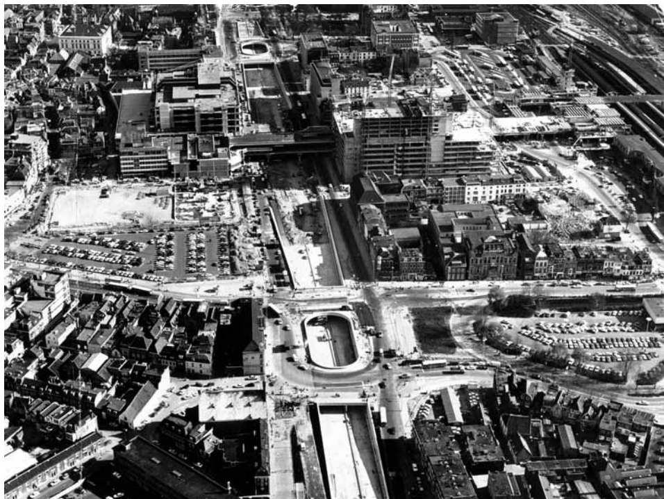
Afbeelding 3: Hoog Catharijne in aanbouw tijdens het begin van de jaren zeventig. Links het Vredenburgplein, in het midden de gedempte Catharijnesingel en rechts de reeds gedeeltelijk gesloopte Stationswijk (Foto: het Utrechts Archief).
