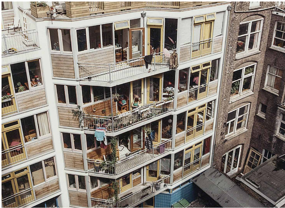
Afb. 12. De achtergevel van de woning van de woongroep in mei 1986. Foto Dienst Ruimtelijke Ordening, Stadsarchief Amsterdam.
