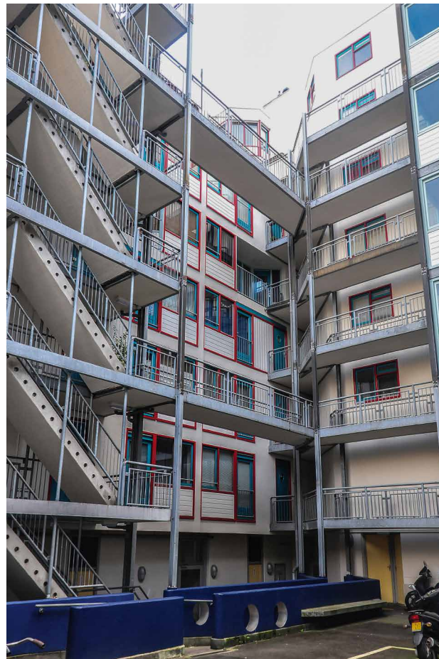
Afb. 14. De binnenplaats met opgang voor fietsen (blauwgeverfd), gezien naar de hoek met de Jodenbreestraat. Foto auteurs, 2017.
