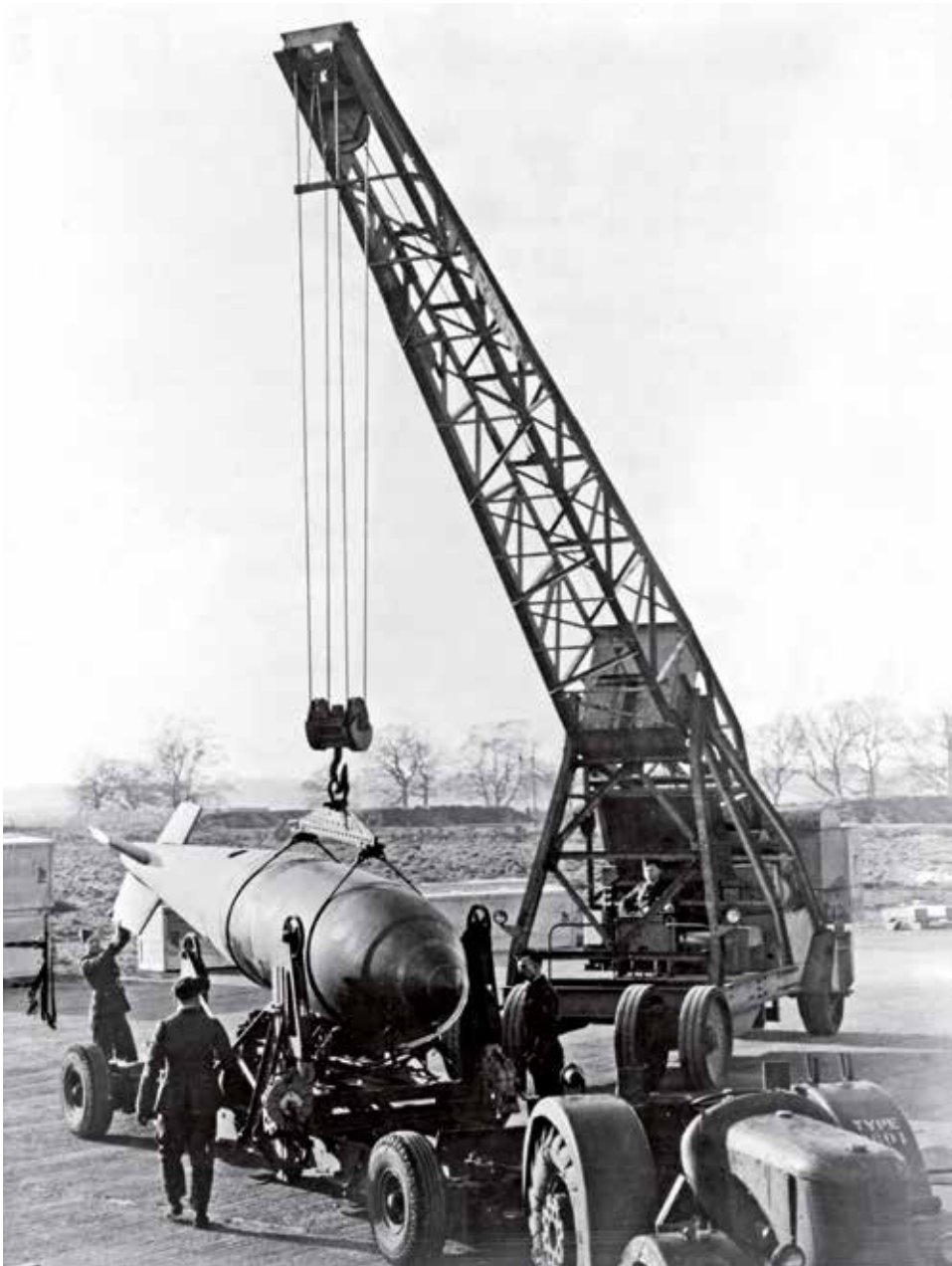
Een 22.000 pond wegende Grand Slam wordt door een kraan op een beladingswagen getild. Dit type bom werd voor het eerst gebruikt op 14 maart 1945 tijdens een bombardement op het viaduct van Bielefeld.
