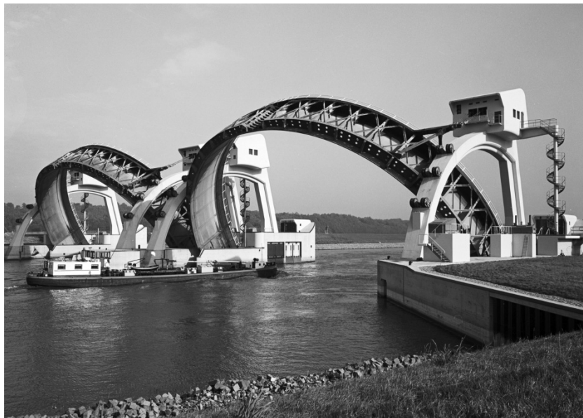
Figure 9.10. Weir in the Nederrijn at Driel, The Netherlands ( https://beeldbank.rws.nl , Rijkswaterstaat).
