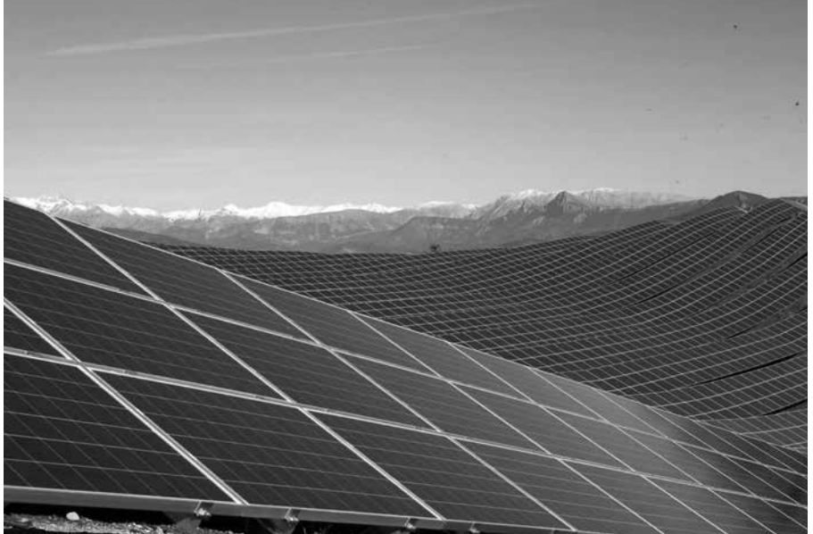
Het zonnepanelen-landschap bij Les Mées. Een typisch grootschalig project met makkelijke ruimteverwerving vanwege grondbezit Franse staat. De eigenaar is een dochtermaatschappij van het Franse staats elektriciteitsbedrijf.
