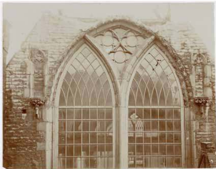
Fig. 8. De Nieuwezijds Kapel tijdens de sloop in 1908 (Bureau Monumenten & Archeologie Amsterdam).
