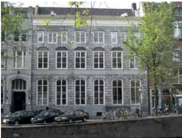
Fig. 5. Herengracht 196, bekleed met blauwe hardsteen (foto auteur).
