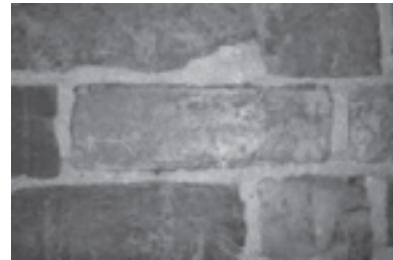
Leiden, Gravensteen algemeen zicht, muurwerk en afstrijkspoor aan de bovenzijde van de baksteen.
