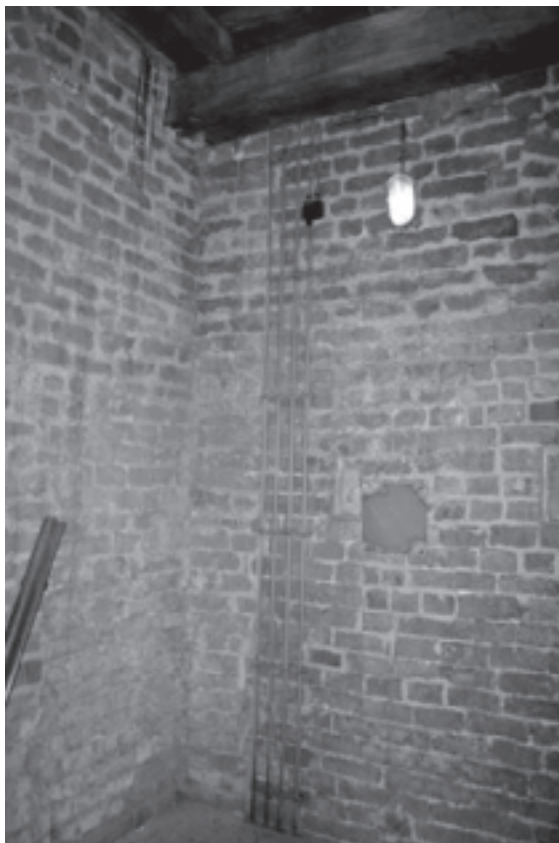
Rijnsburg, Nederlands Hervormde Kerk (voormalige abdijkerk), zuidelijke toren. Overgang van tufsteen naar baksteen.
