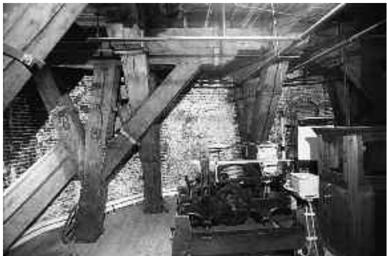
Abb. 5: Montel- baanstoren, Stütz- konstruktion von um 1760.
