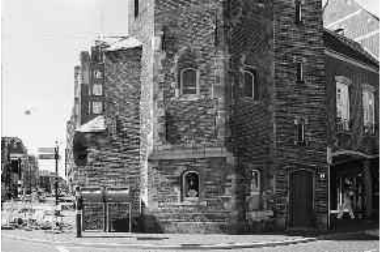
Abb. 9: Die Südostseite des Munttorens, mit links, jetzt als Strebepfeiler, dem letzten Überrest des Torgebäudes; in der Mitte die Vorkragung.
