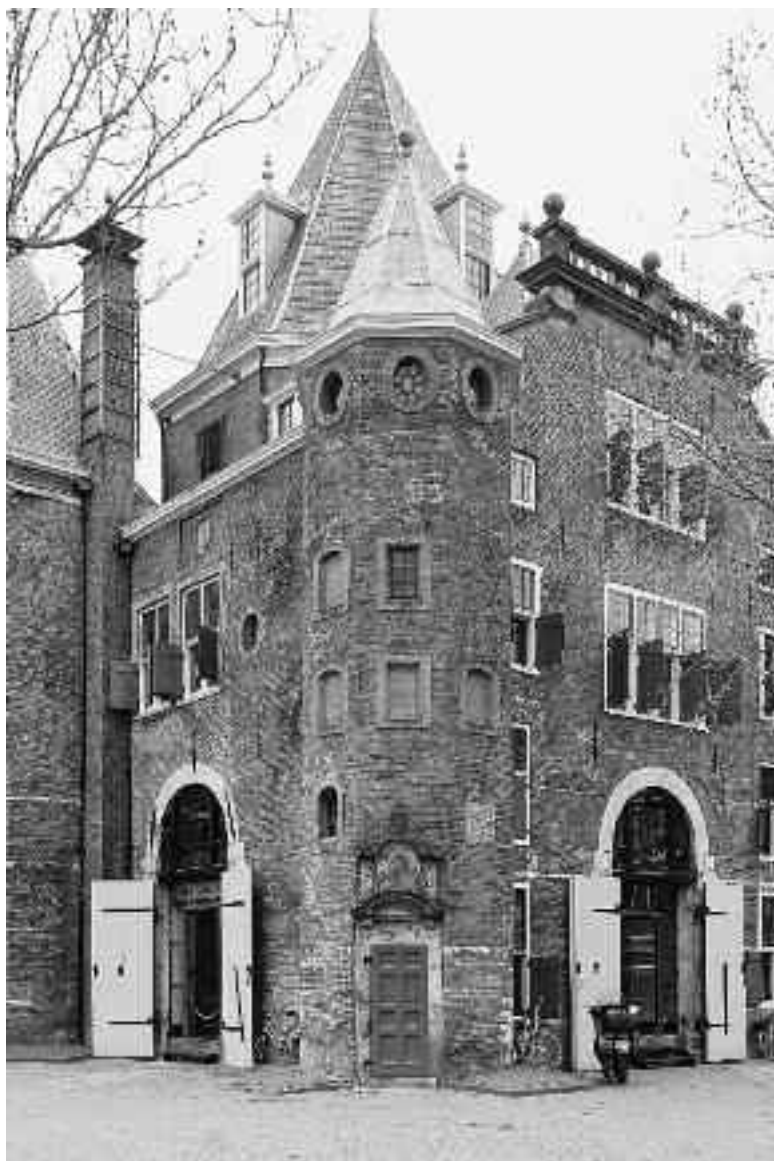
Abb. 14: Der Metselaarstoren im Frühjahr 2009.
