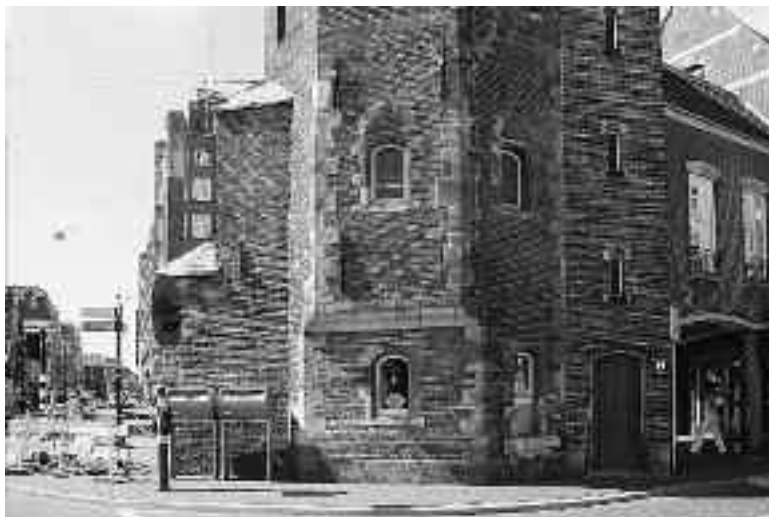
Abb. 9: Die Südostseite des Munttorens, mit links, jetzt als Strebepfeiler, dem letzten Überrest des Torgebäudes; in der Mitte die Vorkragung.
