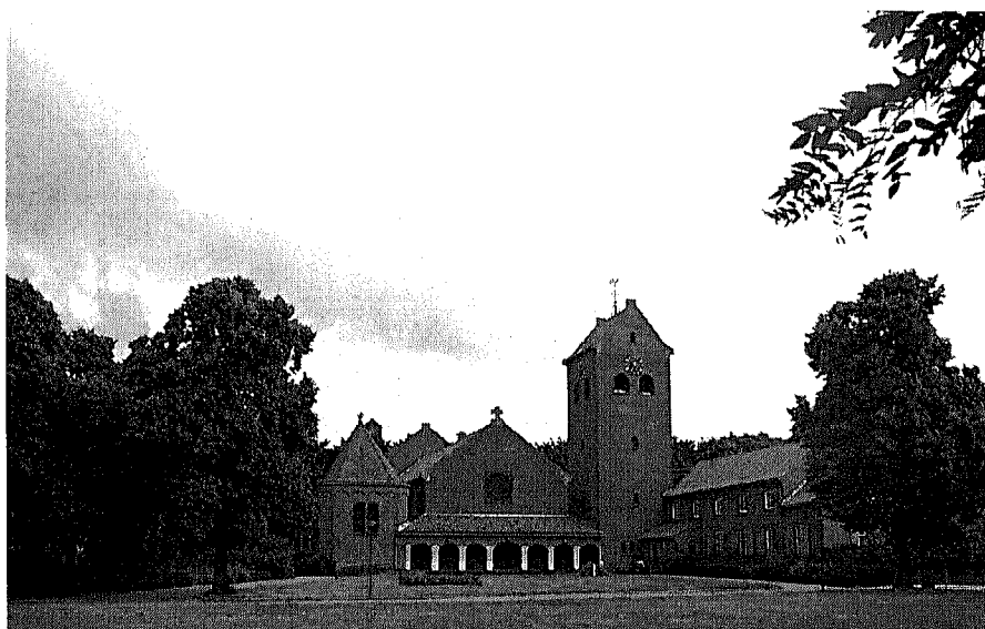
De Jozefkerk tegenwoordig
