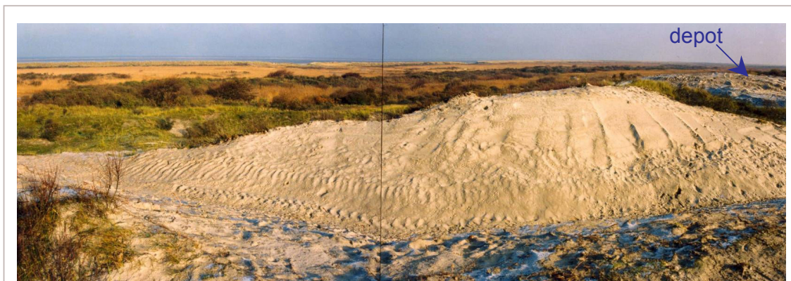
Figuur 2.4: Foto van de kerf direct na de ingreep (november 1993) kijkend in de NO-richting. De afdrukken van de graafmachine zijn nog duidelijk zichtbaar. In de rechtsbovenhoek is een deel van het depot te zien, waar het afgegraven zand weggelegd is.
