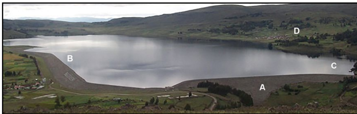
Figura 5. Represa y reservorio. A) presa principal; B) dique lateral margen derecha; C) dique lateral margen izquierda; D) pueblo de Cuchoquesera.
