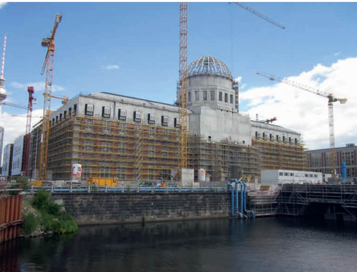
3. Het Berlijnse Stadtschloss in aanbouw, juli 2016 (foto auteur)
