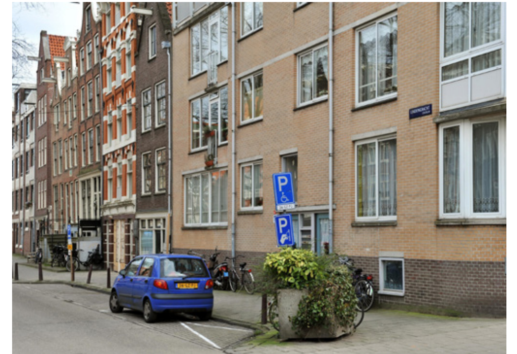
Sociale woningbouw, Lindengracht, Amsterdam
