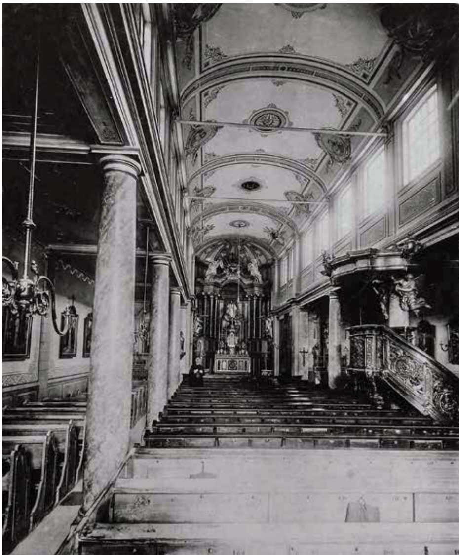
Afb. 6. Foto uit het einde van de negentiende eeuw van de kerk uit 1778, gezien in de richting van het koor aan de kant van de Westerstraat. Westfries Archief, Hoorn.
