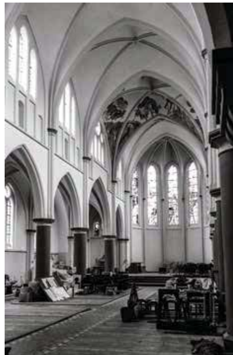
Afb. 16. Inwendige van de kerk gezien naar het koor. Foto G. Vermeer.
