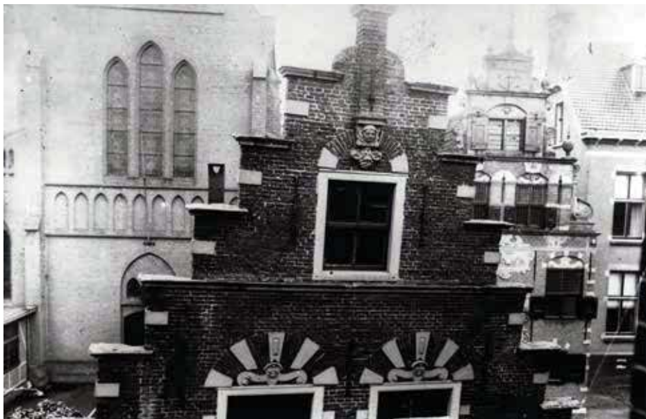
Afb. 13. Op de achtergrond de gevel van de kerk voor de bouw van de toren. Het huis op de voorgrond werd afgebroken vlak voor de bouw van de toren. Digitaal archief Oud Enkhuizen.
