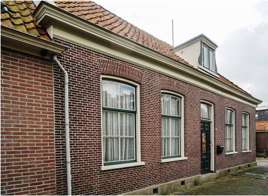
Afb. 3. De voorgevel aan de Noorder Boerenvaart. Foto auteurs.
