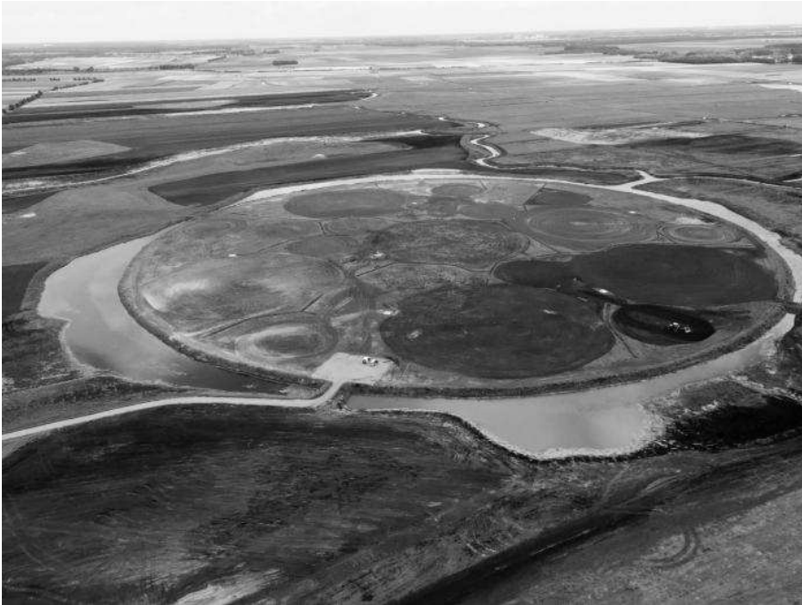
Figure 7.5: Foto uit 2009 van de "superterp" in het binnengebied van de kern van LOFAR, waarop de binnenste kernstations van LOFAR geplaatst zullen worden. Deze terp wordt omringd door een sloot.
